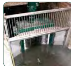
Стальная рама из нержавеющей стали с переливными решетками
